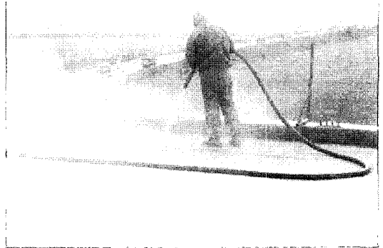
그림 5. 용접부위의 슛블라스팅(shot blasting) 전경
