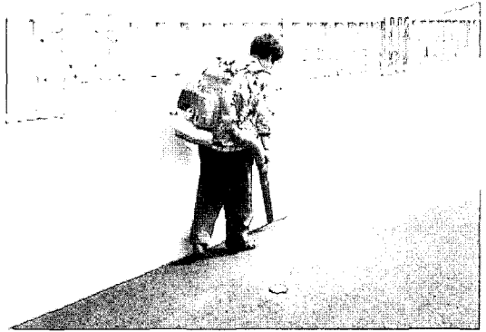
그림 6. 오염 물질 제거를 위한 스위핑(sweeping) 개념의 샌드블라스팅 전경
