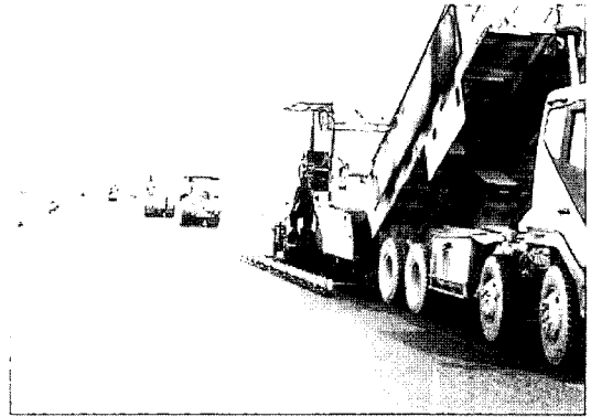
그림 7. SMA 혼합물의 교면포장 시공장면
