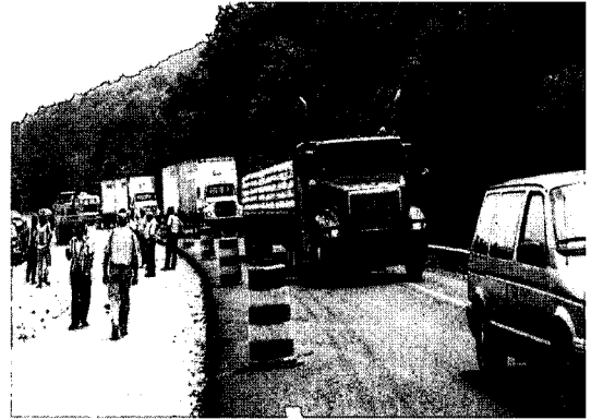
그림 1. 77번 고속도로 보수공사 현장
