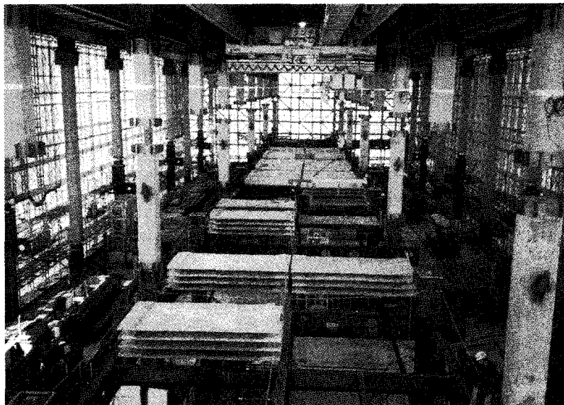
〈사진 6〉 空出물이 없는 하프 PCa판을 사용한 예
