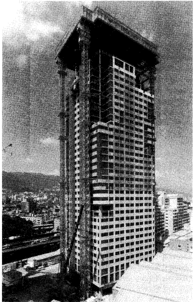
〈사진 2〉 Big-Canopy 공법에 의한 시공 모습
