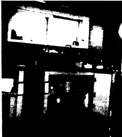
〈그림 5〉 하부수납장 문의 개조 및 휠체어 무릎공간 확보
