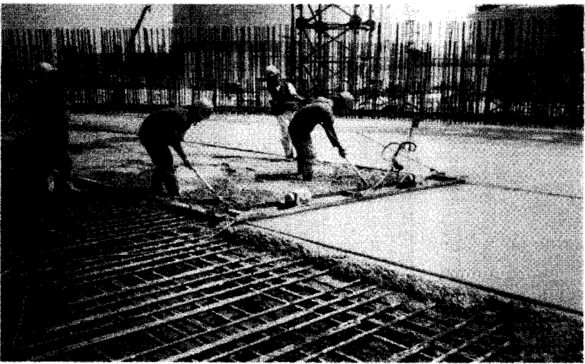
그림 3. 바닥 슬래브의 콘크리트 타설
