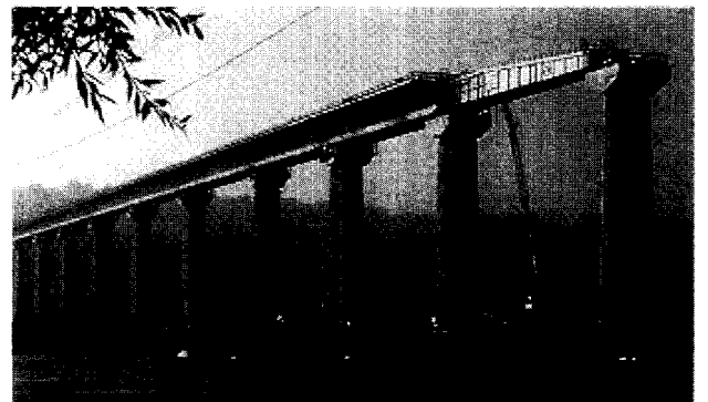
그림 10. 압출 공법으로 시공 중인 교량
