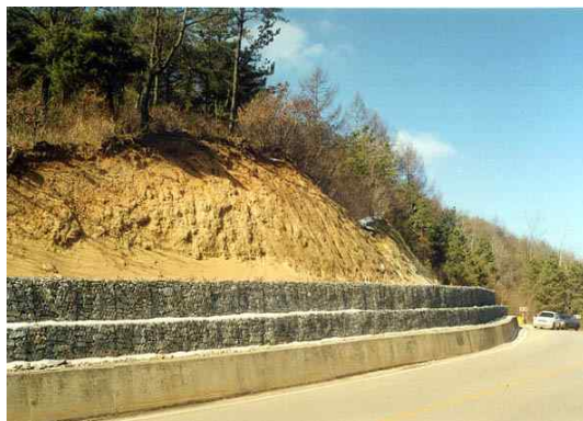
사진 5. 운산 3공구 시공전
