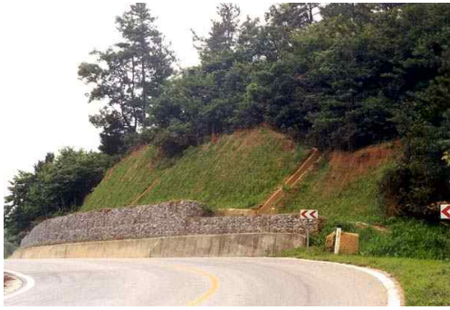
사진 5. 운암3공구 시공3개월후 경관
