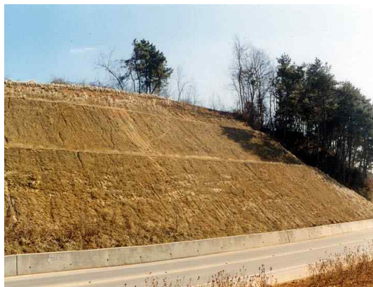
사진 3. 고남 1공구(좌측) 시공전
