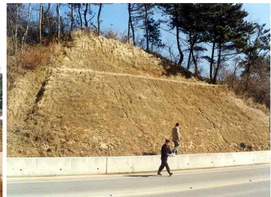
사진 4. 고남 1공구(우측) 시공전
