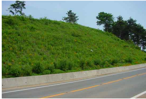
사진 10. 고남1공구(좌측) 시공1년후 경관
