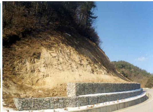
사진 2. 운산 4공구 시공전
