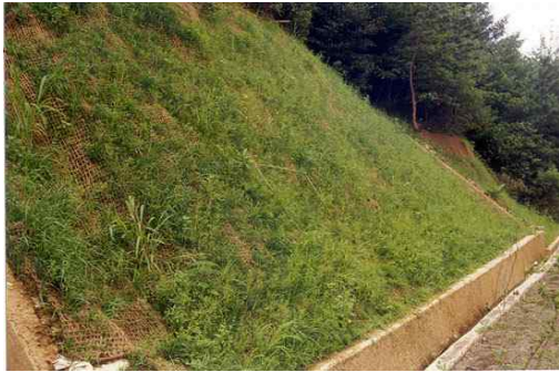
사진 7. 운암4공구 시공3개월후 경관
