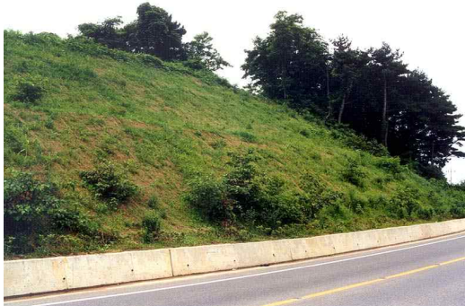
사진 9. 고남1공구(좌측) 시공3개월후 경관
