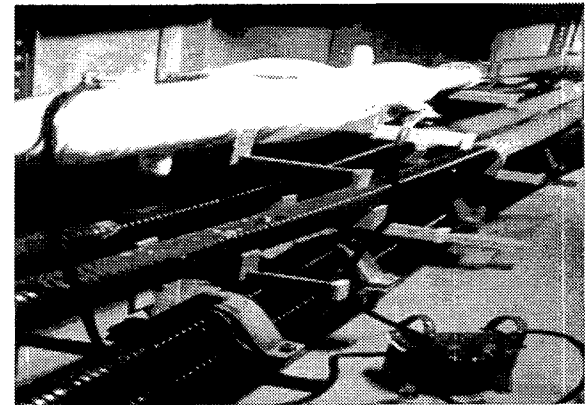
그림 10 시스전류 저감용 리액터 취부 방법 Fig. 10 Adherence method of sheath current reduction equipment(reactor)
