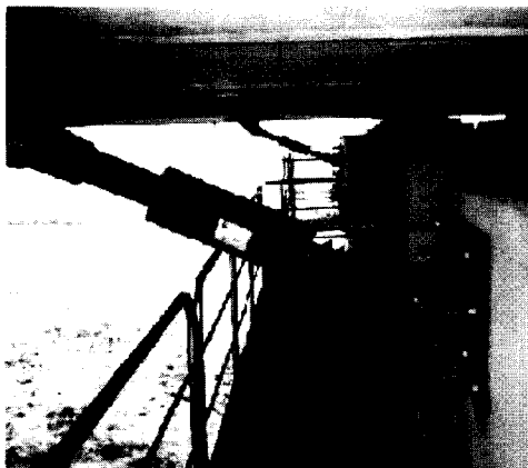
그림 12 교량상판과 교각사이에 viscous damper를 설치한 교량
