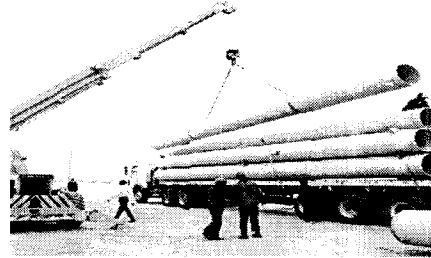
Fig. 3 GRP PIPE 운송 및 공사 현황.
