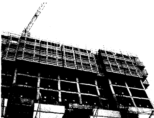
그림 12. 레일 비계 시스템
