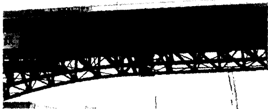
〈사진 4〉 복구교량의 Gerber 연결부분(성수대교)
