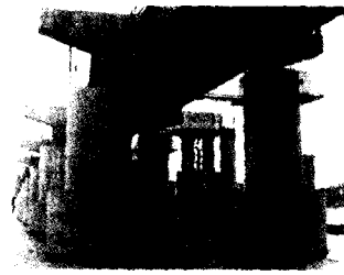
〈사진 5〉 교각 보강 전경(잠실대교)
