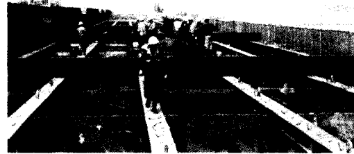
(사진 1) 받침교체를 위한 거더 인상작업(양화대교)
