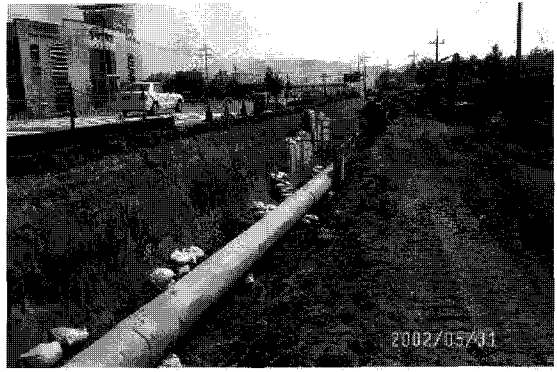
그림 7 배관 매설 공사 현장 모습
