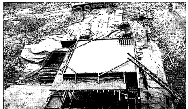
그림 4. Mock-up-test(콘크리트 타설후 전경)
