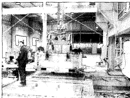
그림 23. 타설 완료후 양생실 이동 광경
