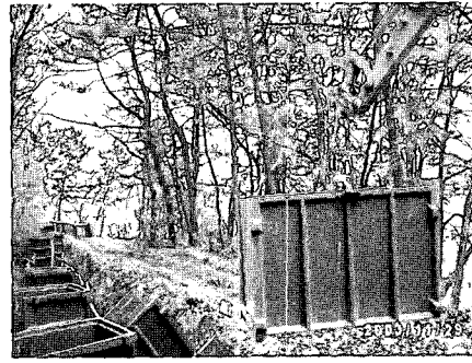
그림 32. 산간부에서 폴리머 콘크리트 조립식개거 설치 광경
