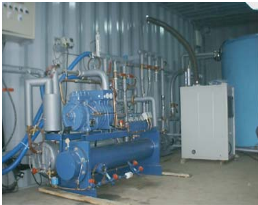
[그림 1] 전체 열펌프 시스템 실물사진
