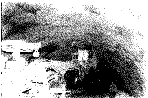
그림 7. 터널 타겟 설치
