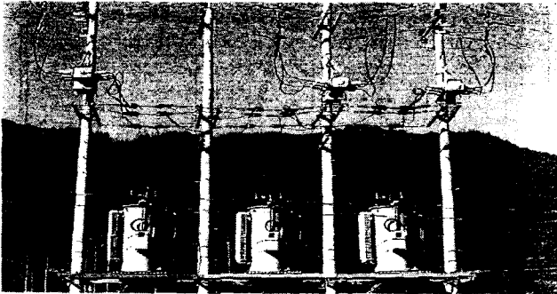
그림 2 선로전압조정장치의 설치도 Fig. 2 Outline of Step Voltage Regulator
