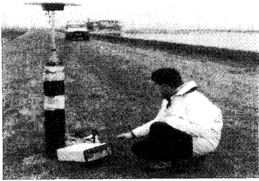
그림 9. Earth Fill Dam상에 설치된 GPS 수신기
