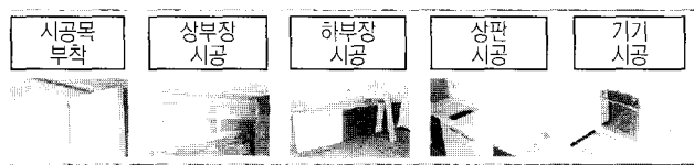
그림 4. 주방 가구공사의 시공순서
