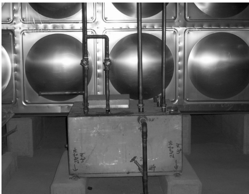
장비설치공사 - 응축수탱크설치 및 배관
