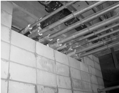
지하2층 기계실벽 관통스리브 설치
