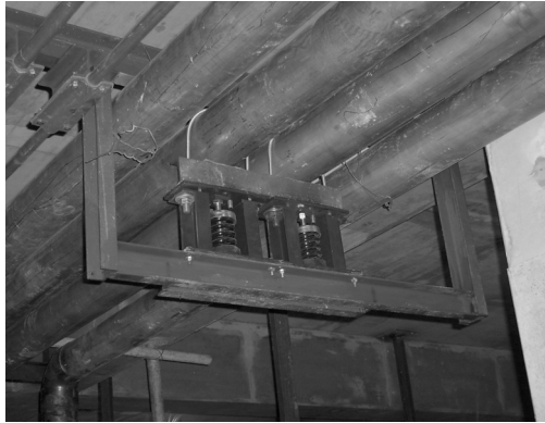
지하2층 기계실 PSM 방진 설치
