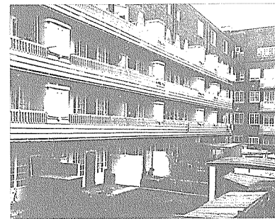
그림 2. 집합주택 주동내부 전경
