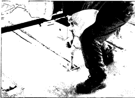
a. 슬래브 폼 설치
