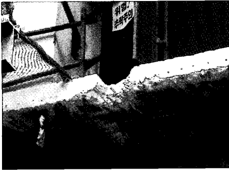
사진 2. 캔티레버 슬래브 하부철근 노출부분의 부식현상
