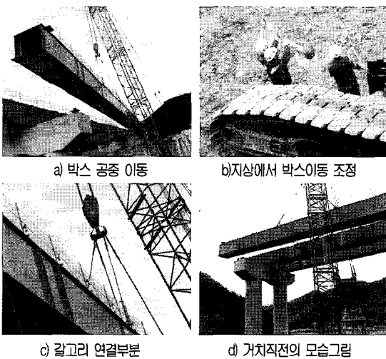
그림 6. 크레인을 이용한 박스 거더 거치
