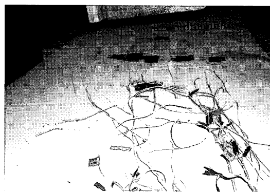
사진 9 델타데크 바닥판 휨 시험후의 상부 파손 모습
