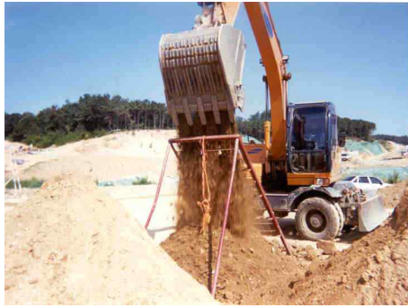
그림 3. 성토재 입도조정을 위한 체가름 모습.
