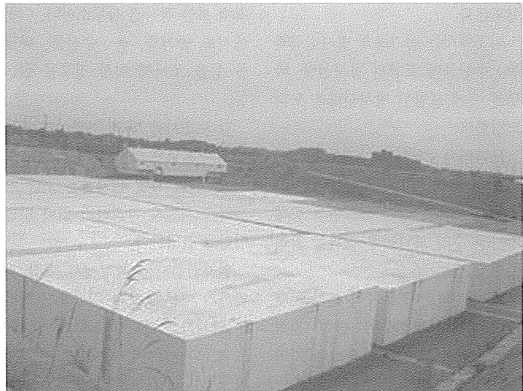
드럼이 가득 채워져 시멘트로 한 번 더 안전 시설을 한 폐기물 처리장. 이 부지가 가득 차면 흙을 덮고 이후로 300년간 관리한다.
