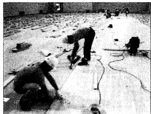
사진 6. 단풍나무 Flooring 시공
