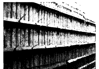
그림 10. C.I.P+Earth Ancho
