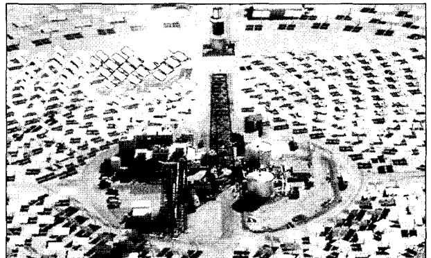
(그림 2) 100MW 급 타워형 태양열발전설비
