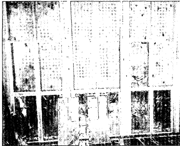
[그림 5] 실험가옥 남북측 벽면에 코어부를 설치하는 광경
