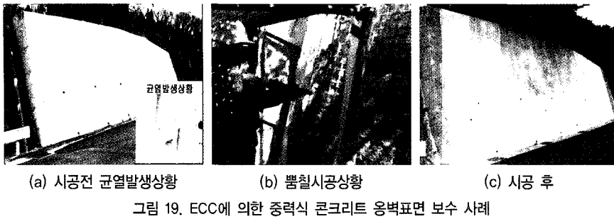
그림 19. ECC에 의한 중력식 콘크리트 응벽표면 보수 사례
