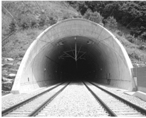
(a) 경부고속철도 터널
