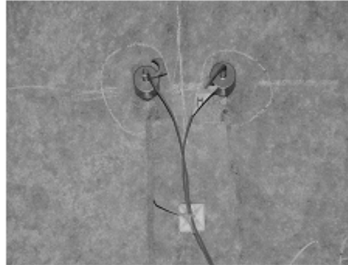
(d) 터널 라이닝에 설치된 가속도계
