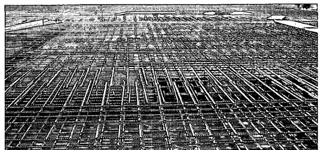
사진4. PF/R SLAB 현장이음철근의 시공
