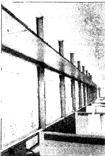
[그림 4] Lightshelf를 설치한 건축물의 내외부 모습
