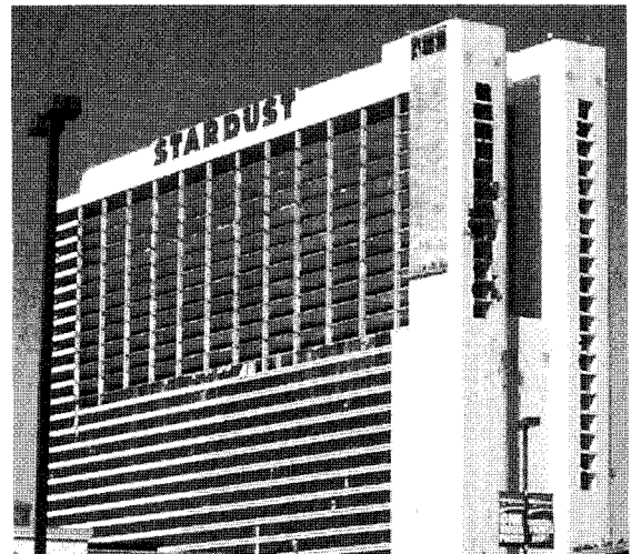
사진 1. 라스베가스 Stardust Hotel Remodeling현장
