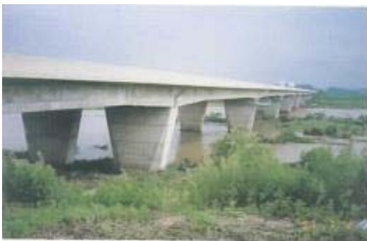
Fig. 1 실험 대상교량 전경
