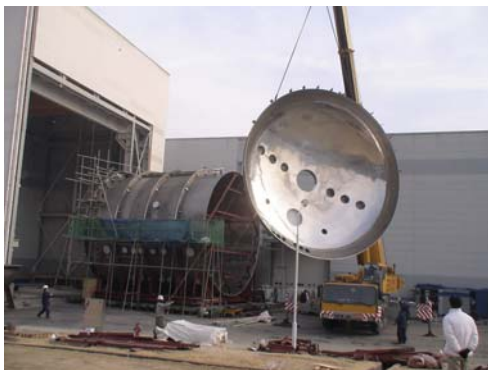
그림 4. 진공용기의 조립 및 용접
