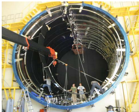
그림 10. 열교환쉬라우드의 설치
