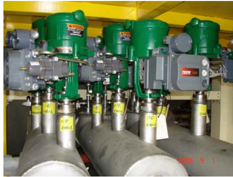
그림 16. 액체질소 유량 조절을 위한 극저온밸브
