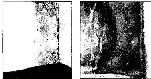
[그림 3] 확장형 발코니 벽체 부위의 결로에 의한 곰팡이 발생사진 (오른쪽 그림은 동일부위의 적외선 열화상 사진)
