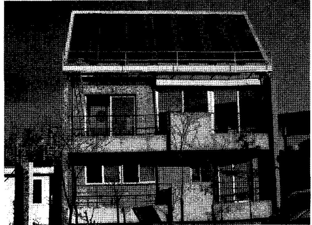
그림 3. 태양열 난방시스템이 설치된 실험주택의 모습
