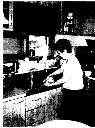
그림 1. 키에 비해 너무 높게 설치되어 접근성이 떨어지는 상부수납장
