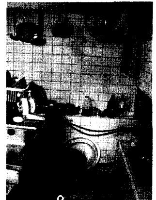
그림 2. 바닥마감과 상부수납장도 없이 매우 열악한 부엌
