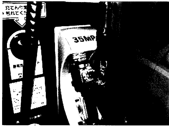
[그림 6] 수소충전기 노즐 및 초고압 수소저장 용기
