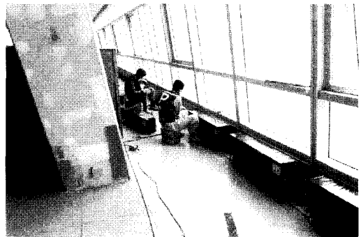
그림 10. ABF(Air Barrier Fan) 설치
