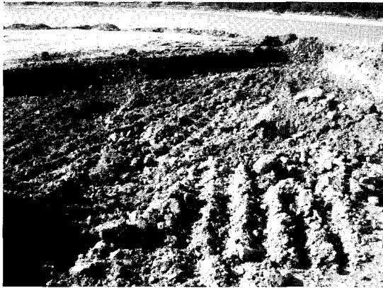
그림 7. 노체 다짐 구간 비온후 상태
