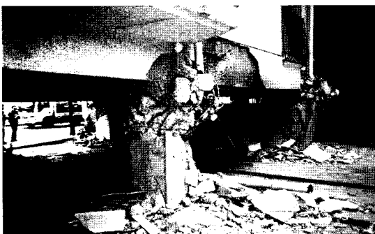
〈그림 1〉 필로티 구조의 지진피해(1995년 일본고베지진)
