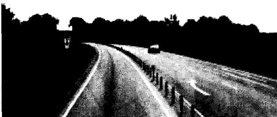
그림 5. "2+1도로"에 케이블 배리어설치(스페인)
