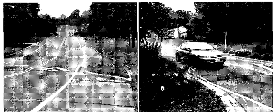
그림 7. 스피드 험프 시설 설치 예
