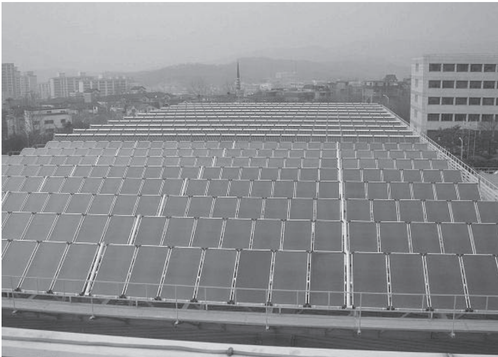
▲ 한국지역난방공사 분당 지사에 설치된 태양열지역난방시스템 집열판
