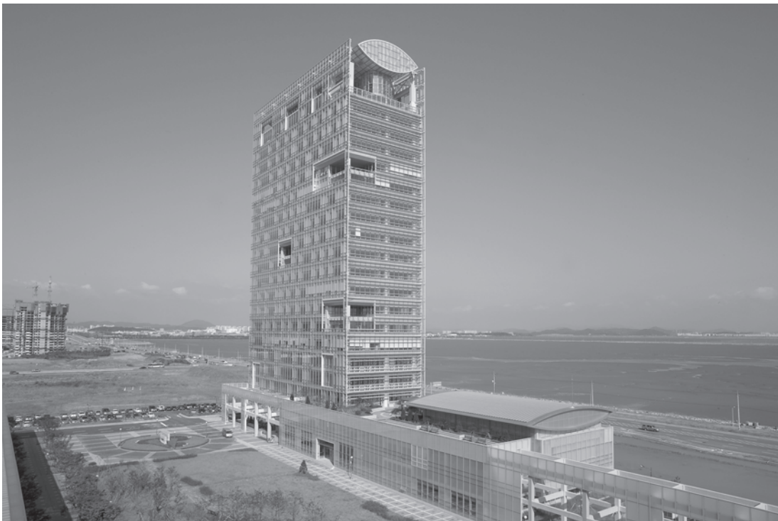
▲ 경남기업(주)이 시공한 인천 송도 벤처빌딩
