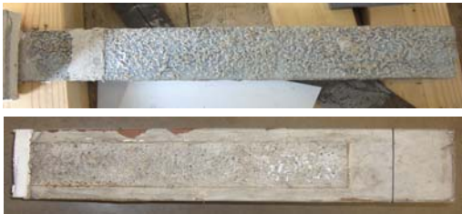
Fig. 5 부착 파괴 후 FRP 판과 콘크리트 면
