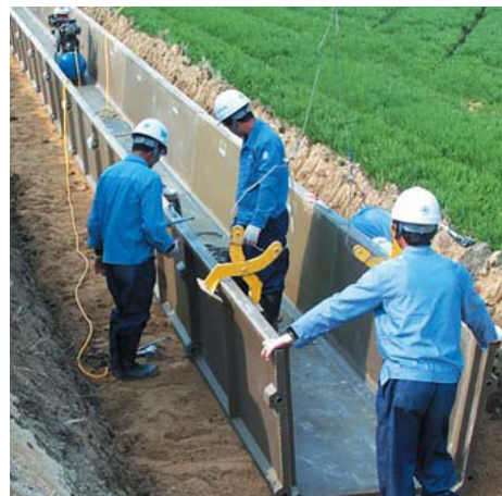
그림 5 관개용수 공급을 위한 irrigation net-work 설치 모습
