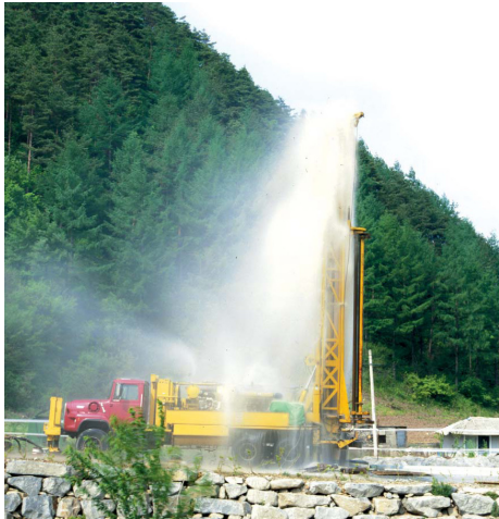
사진 3 지하수 착정작업 모습
